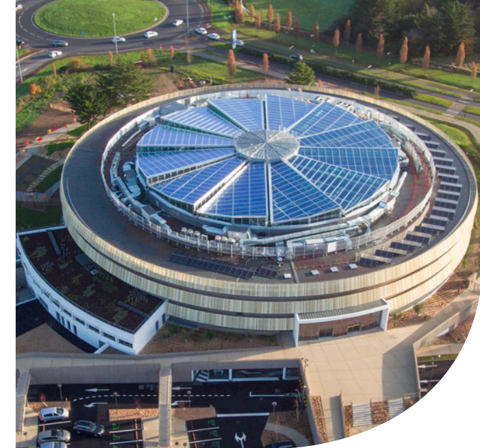
Siège du groupe Avril : une centrale en autoconsommation à Bruz (56)
