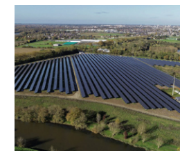
Centrale au sol
