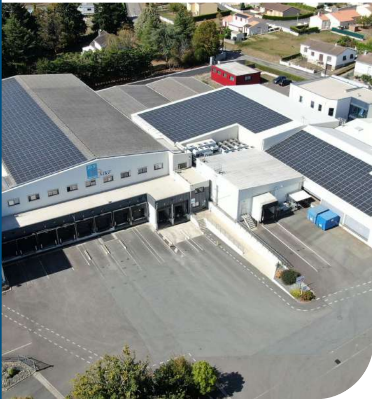
Image : centrale réalisée en technique courante par Solengie sur le toit de DS Restauration (85) avec le système de fixation Hélios B 2 de Dome Solar.
