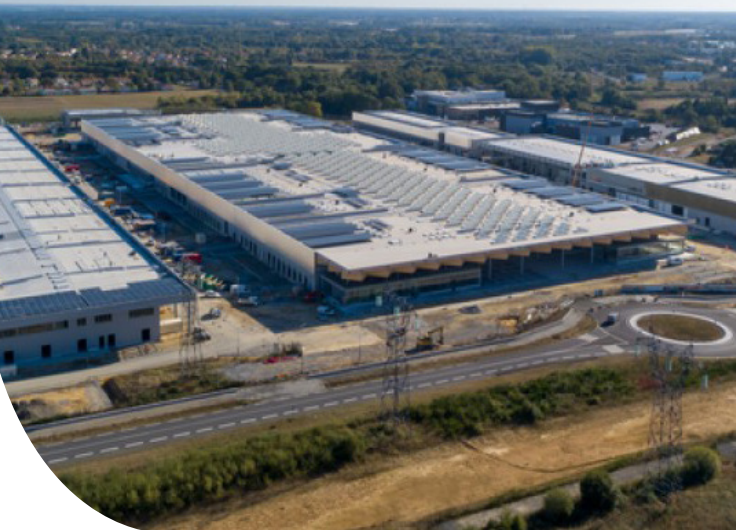
MIN de Nantes (44) - 5,5 MW - mise en service février 2019
