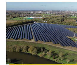
Centrale au sol
